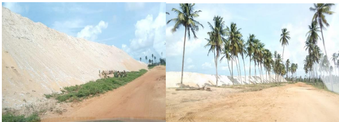
Planche 1 : Rechargement de l'estran le long de la côte à Avlékété
